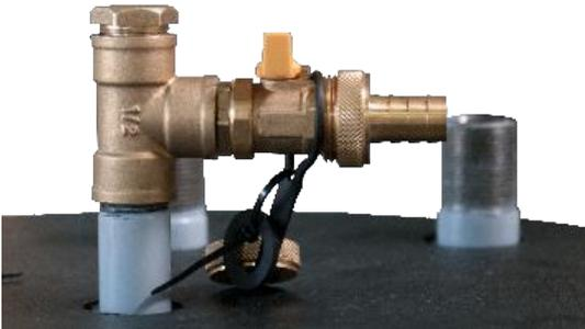
Entfernen Sie den Verschlussstopfen an der Entlüftereinheit (3) der Solbox und installieren diesen in den seitlichen Abgang des oberen T-Stücks der SolBox Erweiterung.
