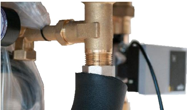
Installieren Sie das Edelstahlwellrohr DN20 an der Unterseite der SolBox und verbinden dieses mit der Unterseite der SolSolBox Erweiterung.
